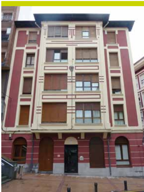
Fachada reformada La Galana, 15
